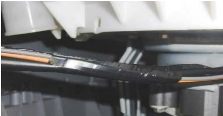
[①水槽結束部を難燃テープで補強]
